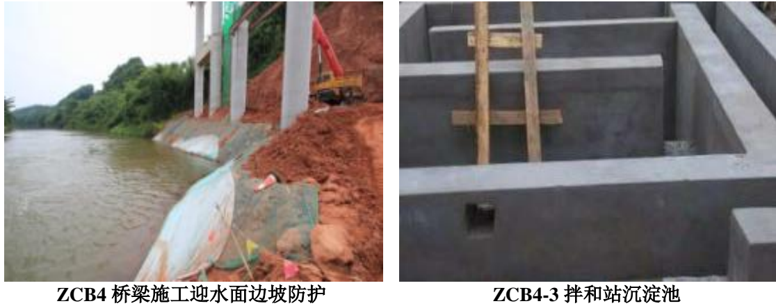
图 8.1-1 施工期水环境保护措施落实情况
