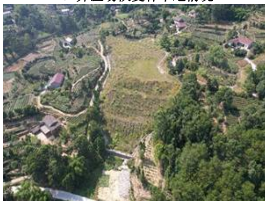
27#弃渣场复耕情况
