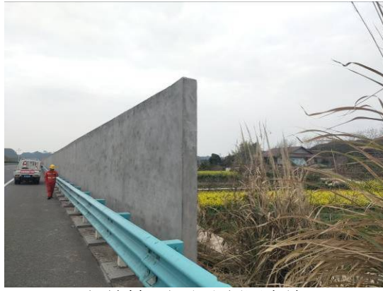
灯坡村 3 组段右侧隔音墙
