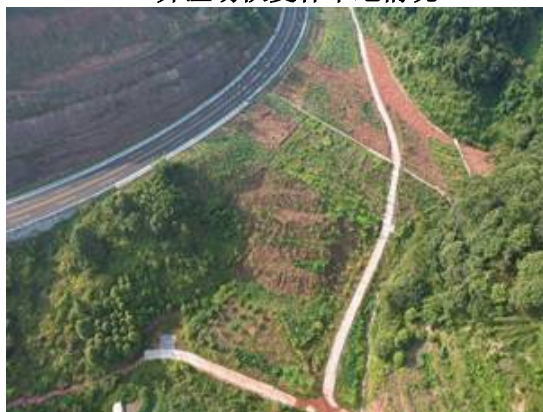
63#弃渣场恢复林草地情况
