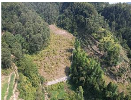
25#弃渣场恢复林草地情况
