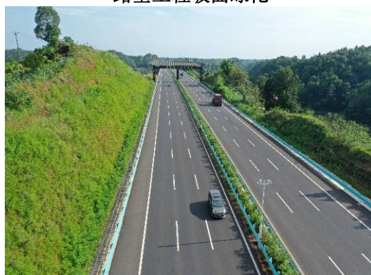
路基工程坡面绿化
