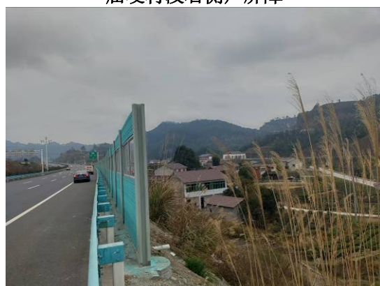
宴家桥村 2 组段右侧声屏障
