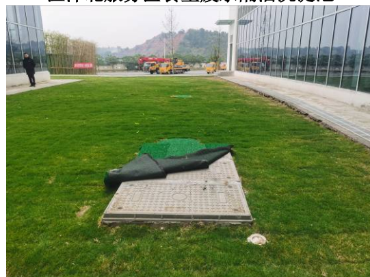
谢安服务区食堂废水隔油沉淀池
