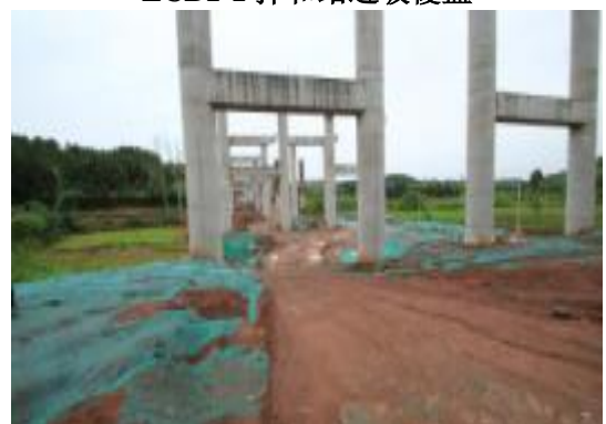
ZCB1-3 桥梁开挖面遮盖
