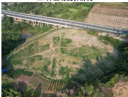
13#弃渣场复耕情况
