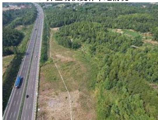
20#弃渣场恢复林草地情况
