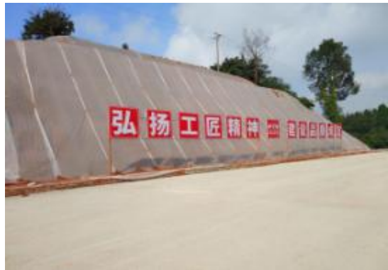
ZCB4 路基边坡临时苫盖
