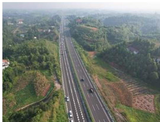
58#弃渣场复耕情况
