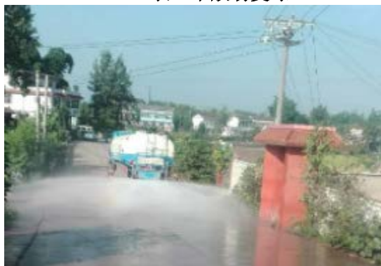
ZCB2 施工场地洒水降尘
