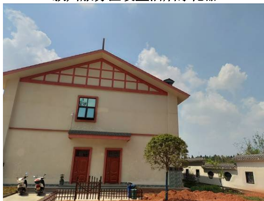
合什收费站食堂油烟高空排放
