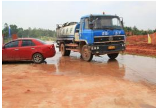
ZCB4 施工道路洒水降尘
