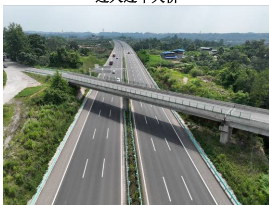
过人过车天桥
