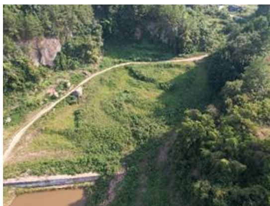
17#弃渣场恢复林草地情况
