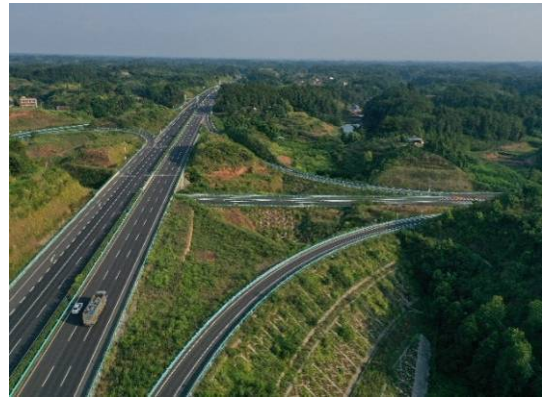
路基工程坡面绿化
