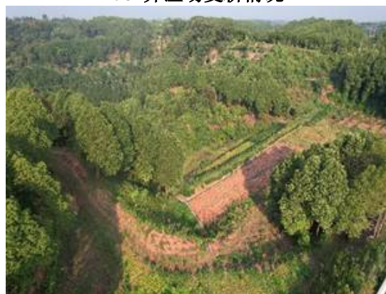
60#弃渣场恢复林草地情况
