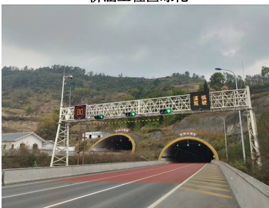
华阳山隧道工程区绿化
