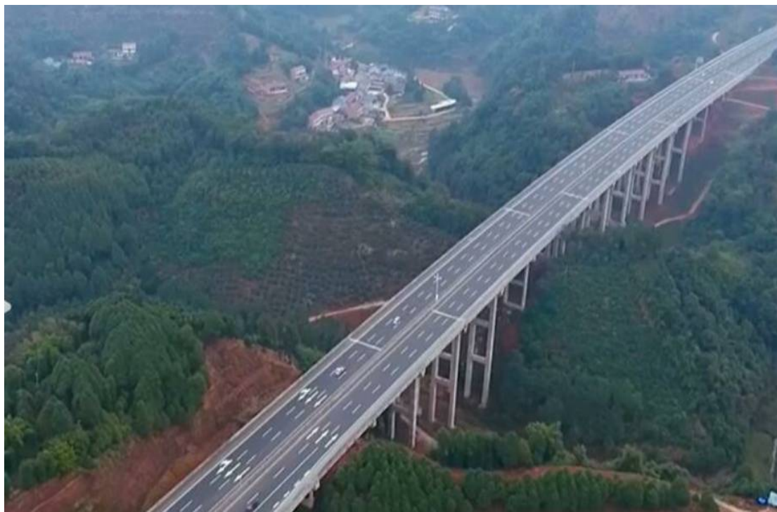
沙子沟特大桥
