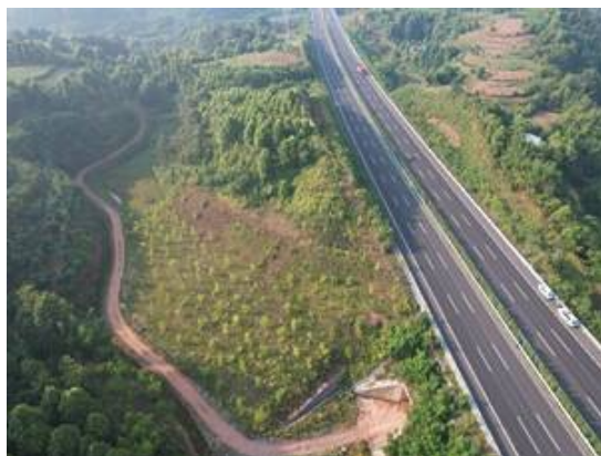
57#弃渣场恢复林草地情况
