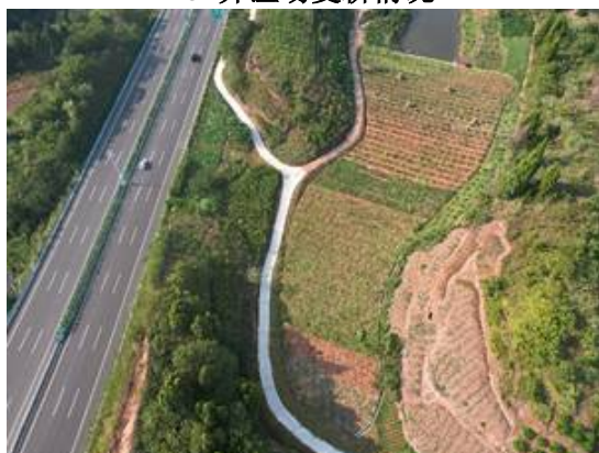
47#弃渣场复耕情况
