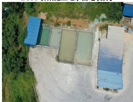
五黄坝大桥拌和站泥浆沉淀池
