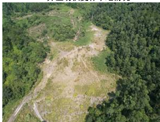
24#弃渣场恢复林草地情况
