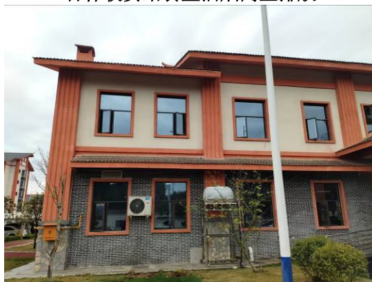
龙马收费站食堂油烟高空排放
