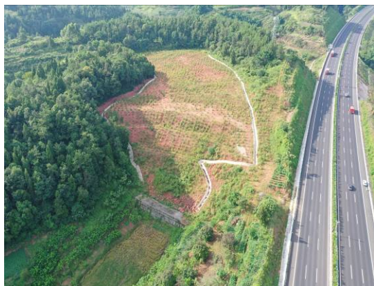
49#弃渣场恢复林草地情况
