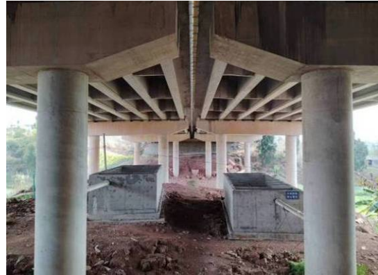
余家湾大桥隔油沉淀池
