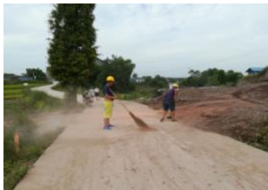
ZCB3 施工道路清扫
