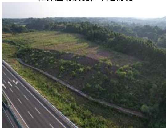
8#弃渣场恢复林草地情况
