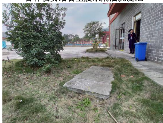
河口收费站食堂废水隔油沉淀池
