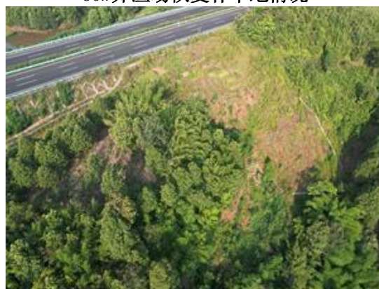
62#弃渣场恢复林草地情况
