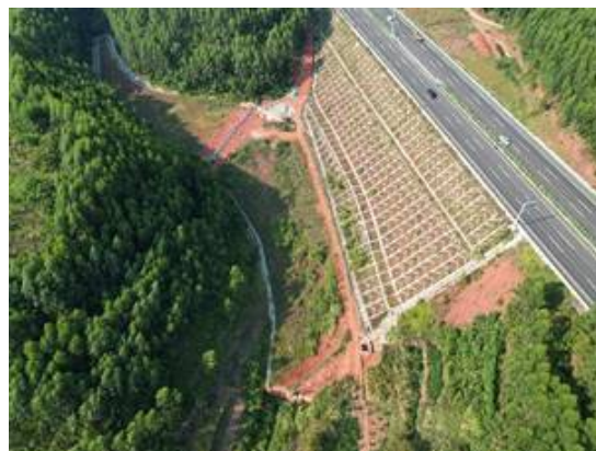
42#弃渣场恢复林草地情况
