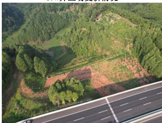
61#弃渣场恢复林草地情况
