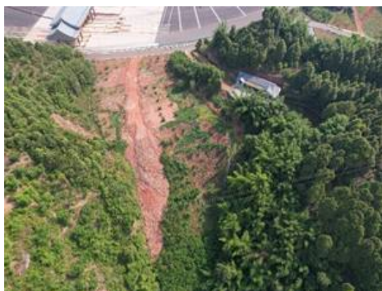
65#弃渣场恢复林草地情况
