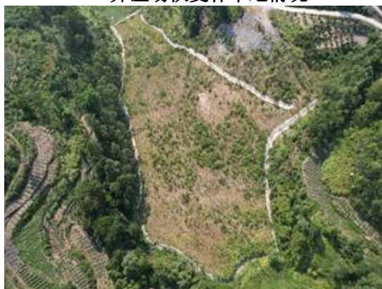
23#弃渣场恢复林草地情况
