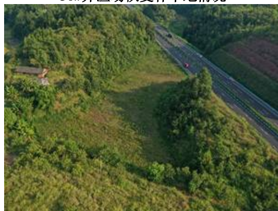
52#弃渣场恢复林草地情况
