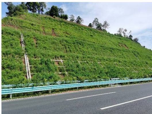
路基工程坡面绿化
