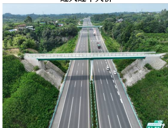
过人过车天桥
