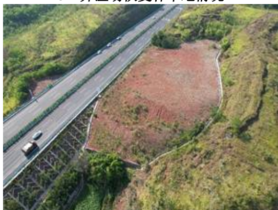
39#弃渣场复耕情况
