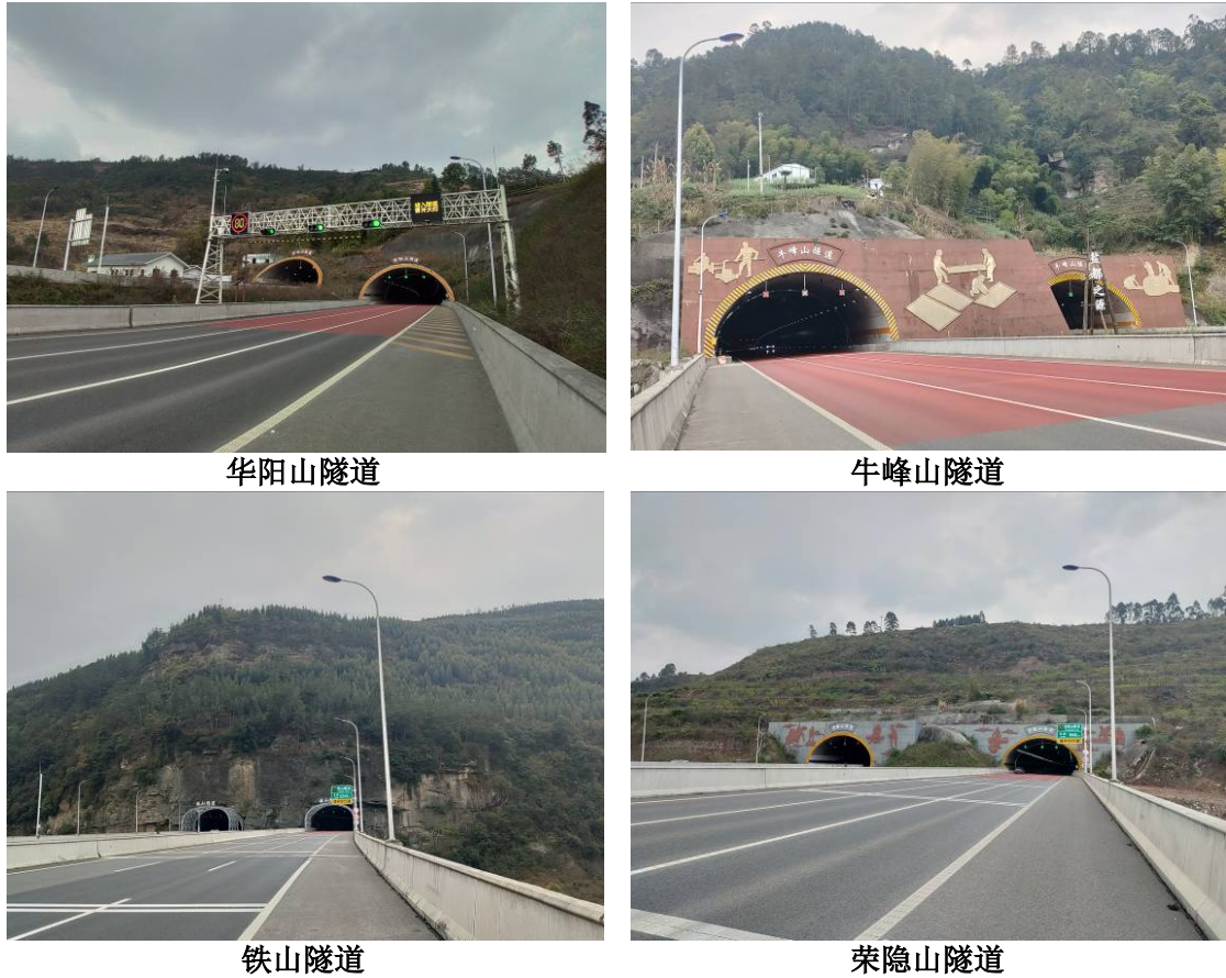
图 3.3-3 隧道工程建设情况实景图
