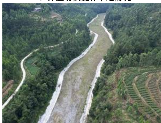
30#弃渣场恢复林草地情况
