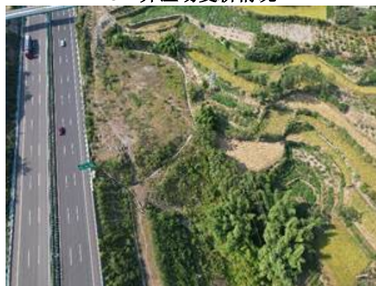
36#弃渣场恢复林草地情况
