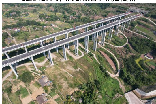
五皇坝大桥施工场地复耕
