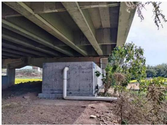
伍家坝大桥隔油沉淀池
