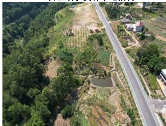
32#弃渣场恢复林草地情况
