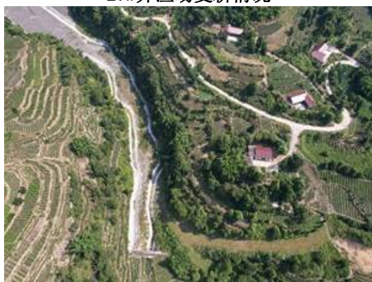
29#弃渣场恢复林草地情况
