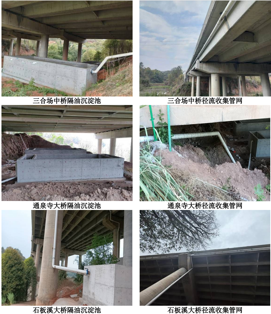
图 8.2-2 跨河桥梁径流收集系统建设情况
