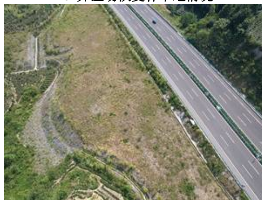
28#弃渣场恢复林草地情况
