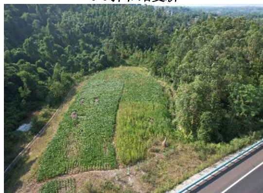
渣场区施工便道绿化
