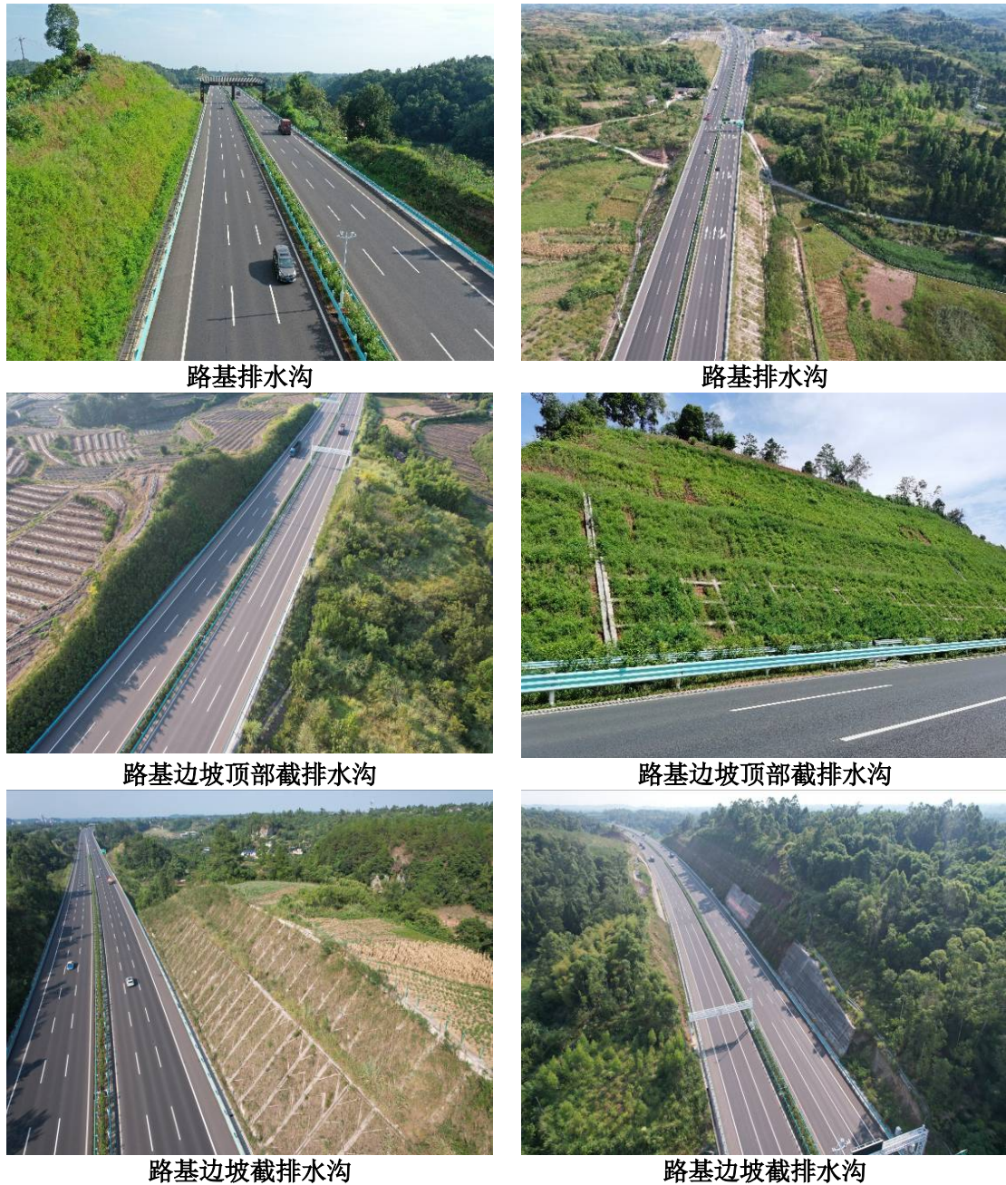
图 8.2-1 路面排水系统建设情况
