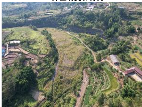
35#弃渣场恢复林草地情况
