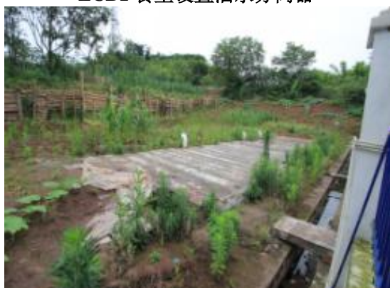
ZCB2-1 项目部生活污水预处理池
