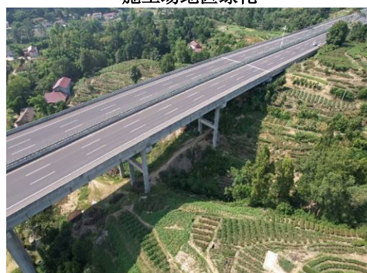
桥梁工程区施工场地复耕
