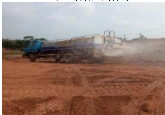
ZCB3 施工场地洒水降尘
