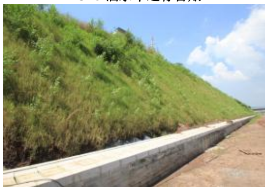
ZCB3 路基边坡绿化
