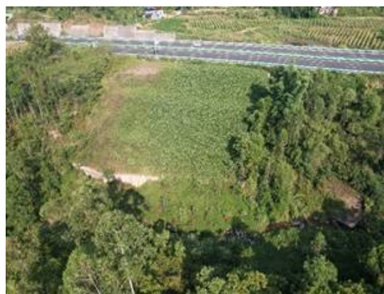
18#弃渣场恢复林草地情况
