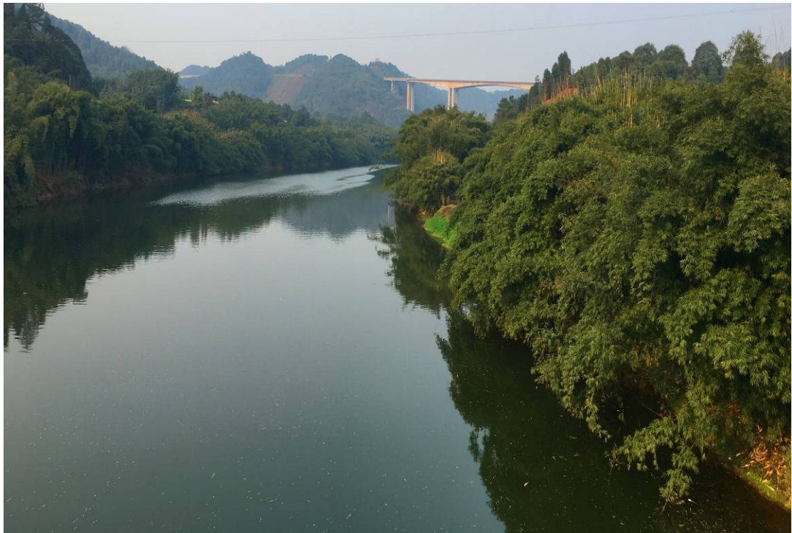
风景区视觉的成宜高速公路
