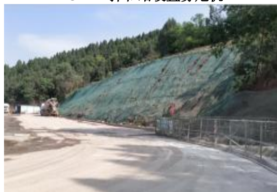
ZCB1-1 拌和站边坡覆盖
