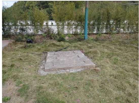
樟海收费站食堂废水隔油沉淀池
