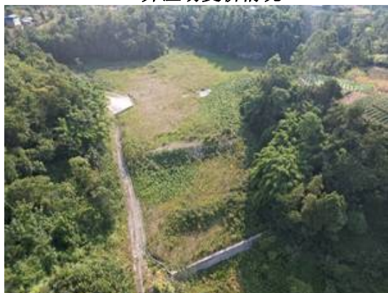
15#弃渣场恢复林草地情况
