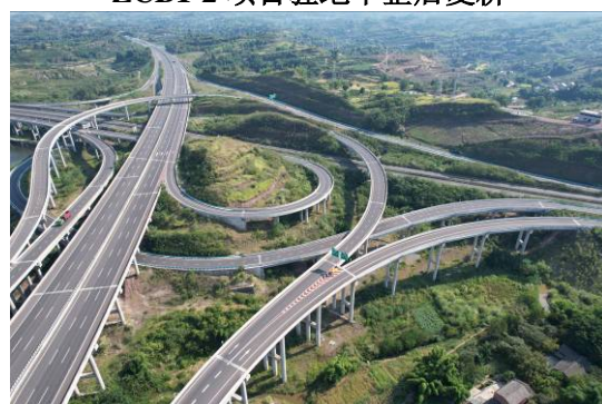
荣州枢纽互通施工场地绿化
