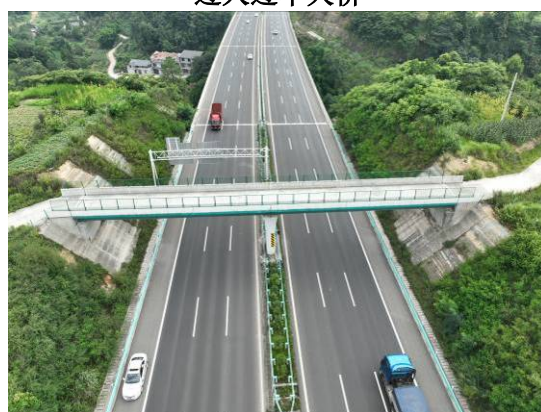
过人过车天桥
