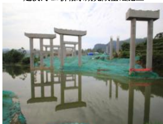
ZCB3 桥梁施工迎水面边坡防护
