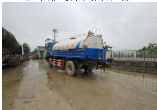
ZCB2 拌和站洒水降尘
