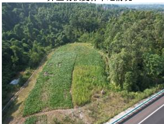
19#弃渣场恢复林草地情况
