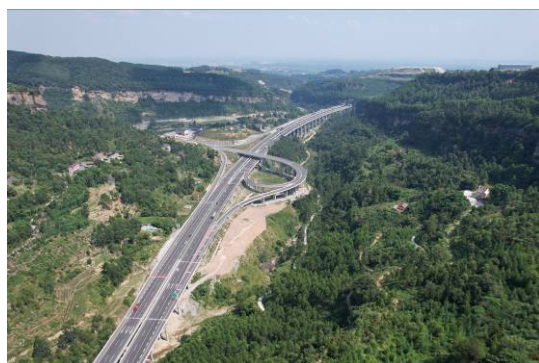
铁厂互通施工场地平整后用于复耕
