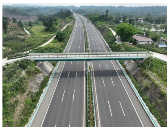
过人过车天桥
