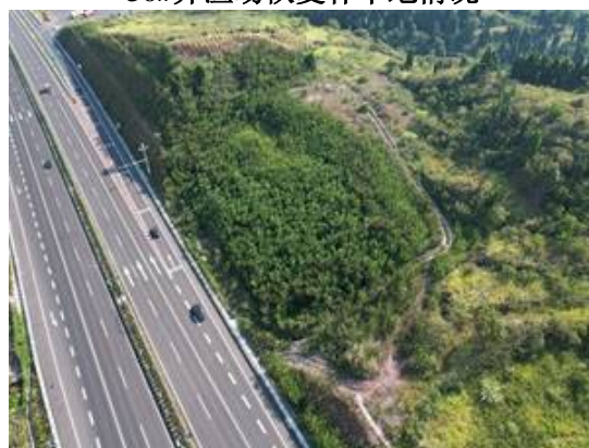
38#弃渣场恢复林草地情况
