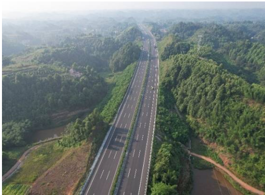
路基工程坡面绿化
