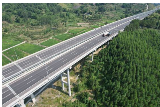
桥梁工程区施工场地复耕
