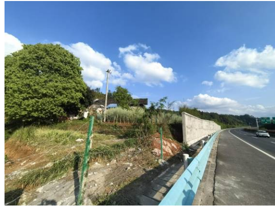
钟河村东风组段左侧隔音墙
