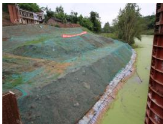
清水河大桥施工迎水面边坡防护
