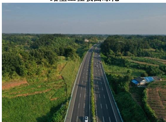
路基工程坡面绿化
