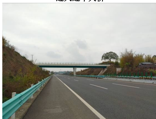
过人过车天桥
