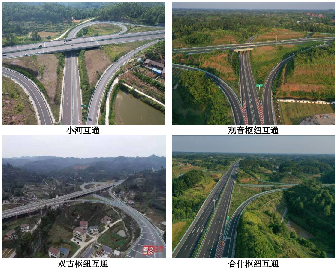
图 3.3-4 部分交叉工程建设情况实景图
