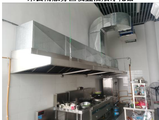
谢安服务区设置油烟净化器
