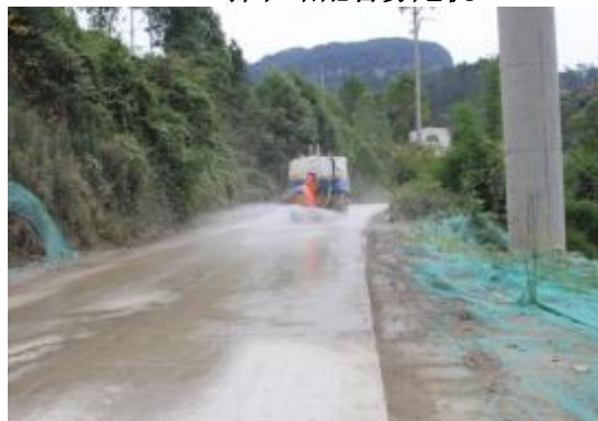
ZCB2 施工道路洒水降尘
