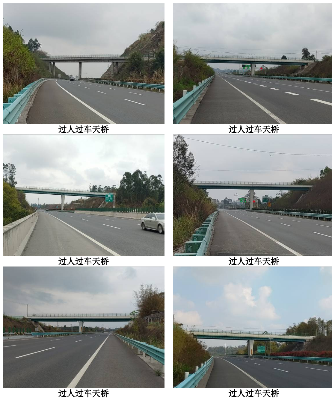
图 11.2-1 部分立交、通道及涵洞建设情况
