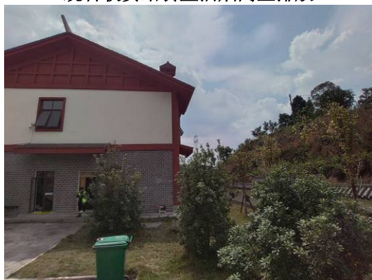
河口收费站食堂油烟高空排放
