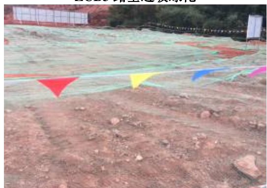
ZCB4-3 表土覆盖
