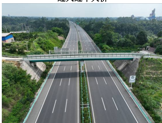
过人过车天桥
