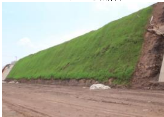
ZCB3 路基边坡绿化
