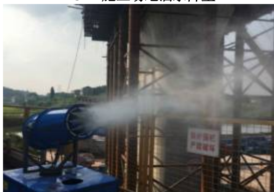
ZCB2 施工现场配备雾炮机
