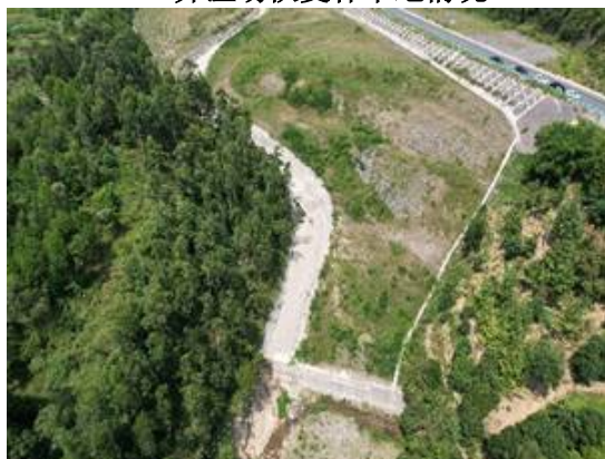
31#弃渣场恢复林草地情况
