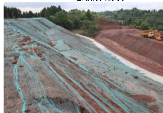
ZCB1 弃土场遮盖
