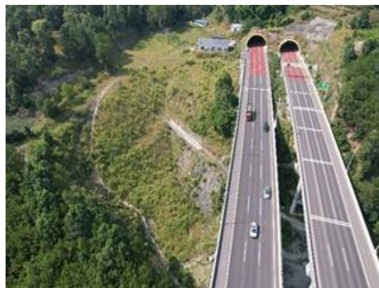
26#弃渣场恢复林草地情况
