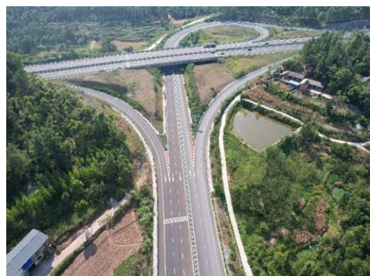
施工场地区绿化
