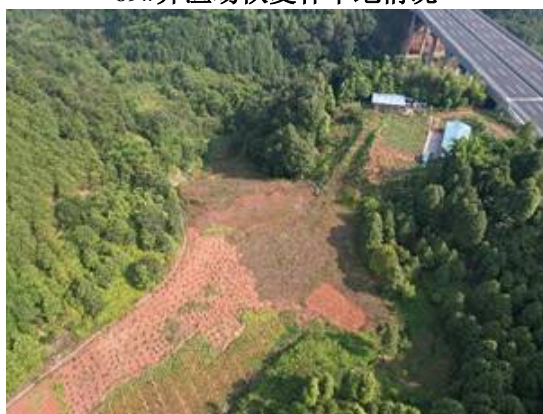
71#弃渣场复耕情况
