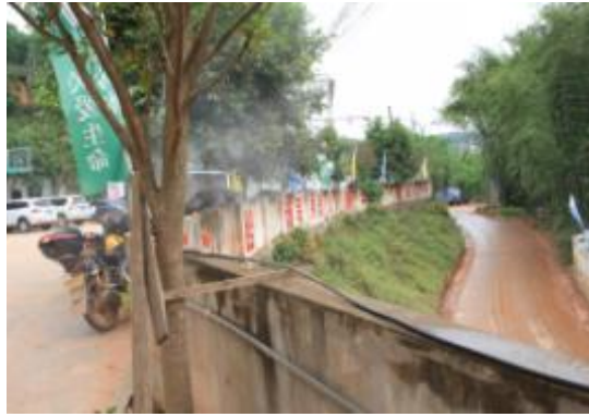
ZCB4 标施工场地喷雾降尘
