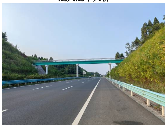
过人过车天桥
