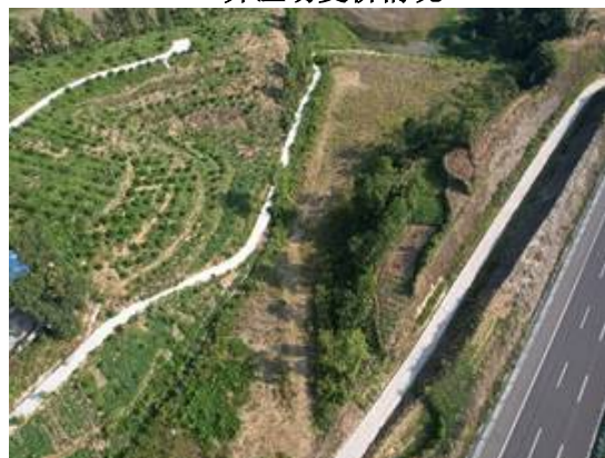
16#弃渣场恢复林草地情况
