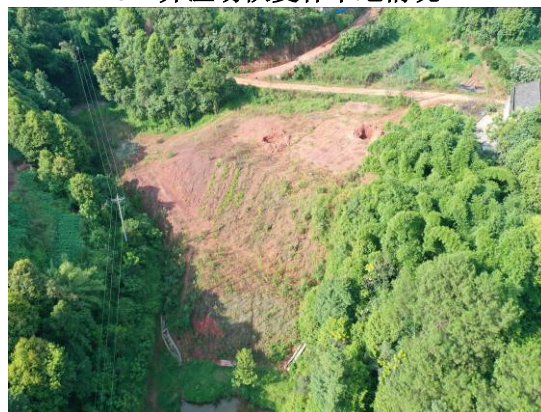
54#弃渣场恢复林草地情况
