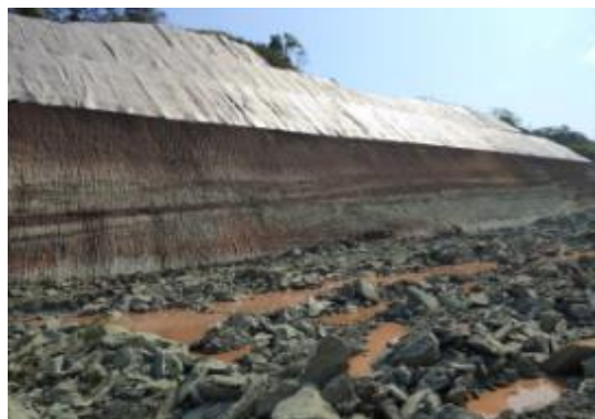
路基裸露边坡采取临时苫盖措施
