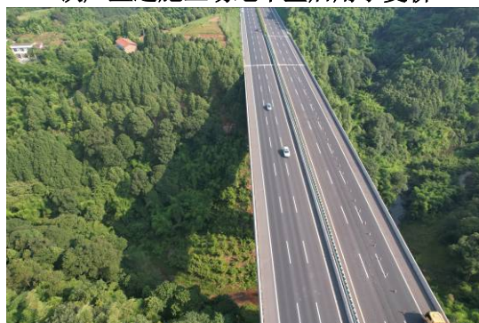
向阳咀大桥施工场地复耕
