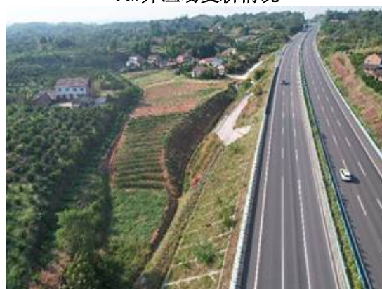
46#弃渣场复耕情况
