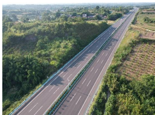
路基工程坡面绿化
