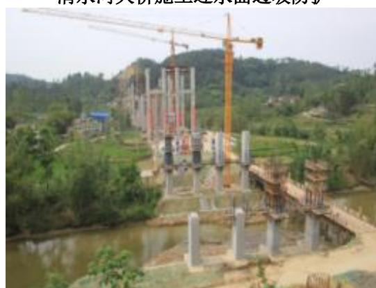
越溪河 2#桥枯水期完成基础施工
