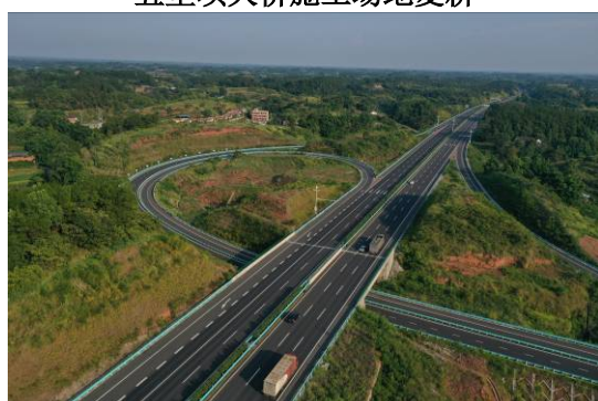
合什枢纽互通施工场地绿化
