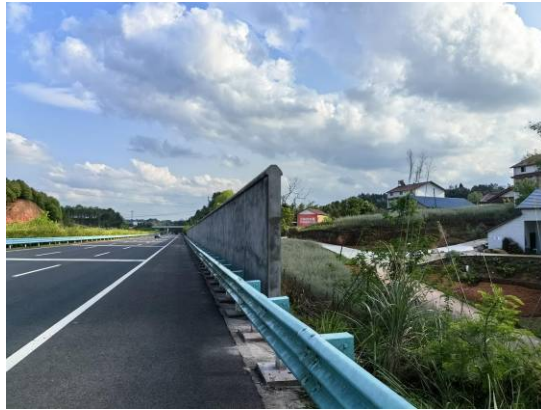
老店村明权组段右侧隔音墙
