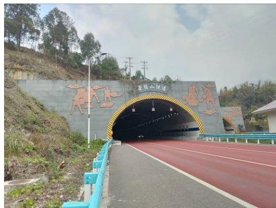
荣隐山隧道工程区景观绿化
