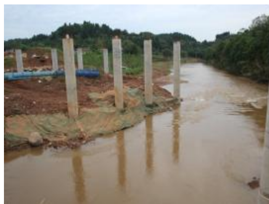
ZCB1 涉水桥梁施工迎水面边坡防护
