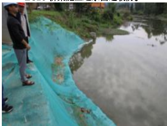
庙门咀大桥施工迎水面边坡防护
