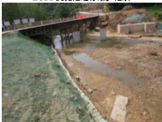
ZCB3 桥梁施工迎水面边坡防护
