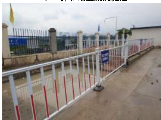
ZCB2 拌和站五级沉淀池
