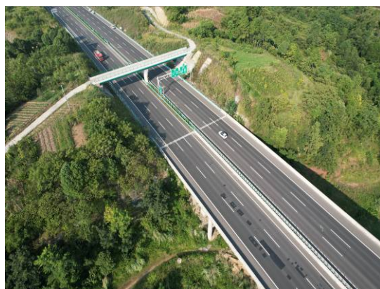
过人过车天桥
